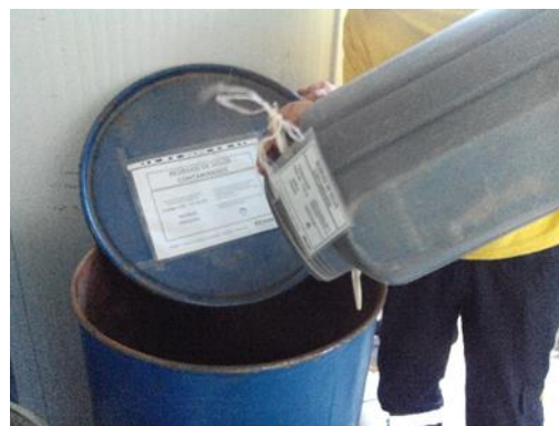
Fig. 6 – Colocação do produto contaminado em zona própria do Estaleiro (contentor de solos contaminados), para encaminhamento ao operador de resíduos.
