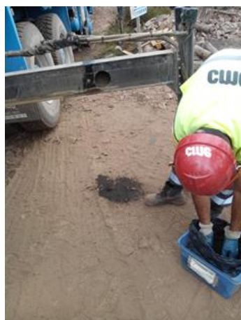
Fig. 3 – Colocação de Produto Absorvente.
